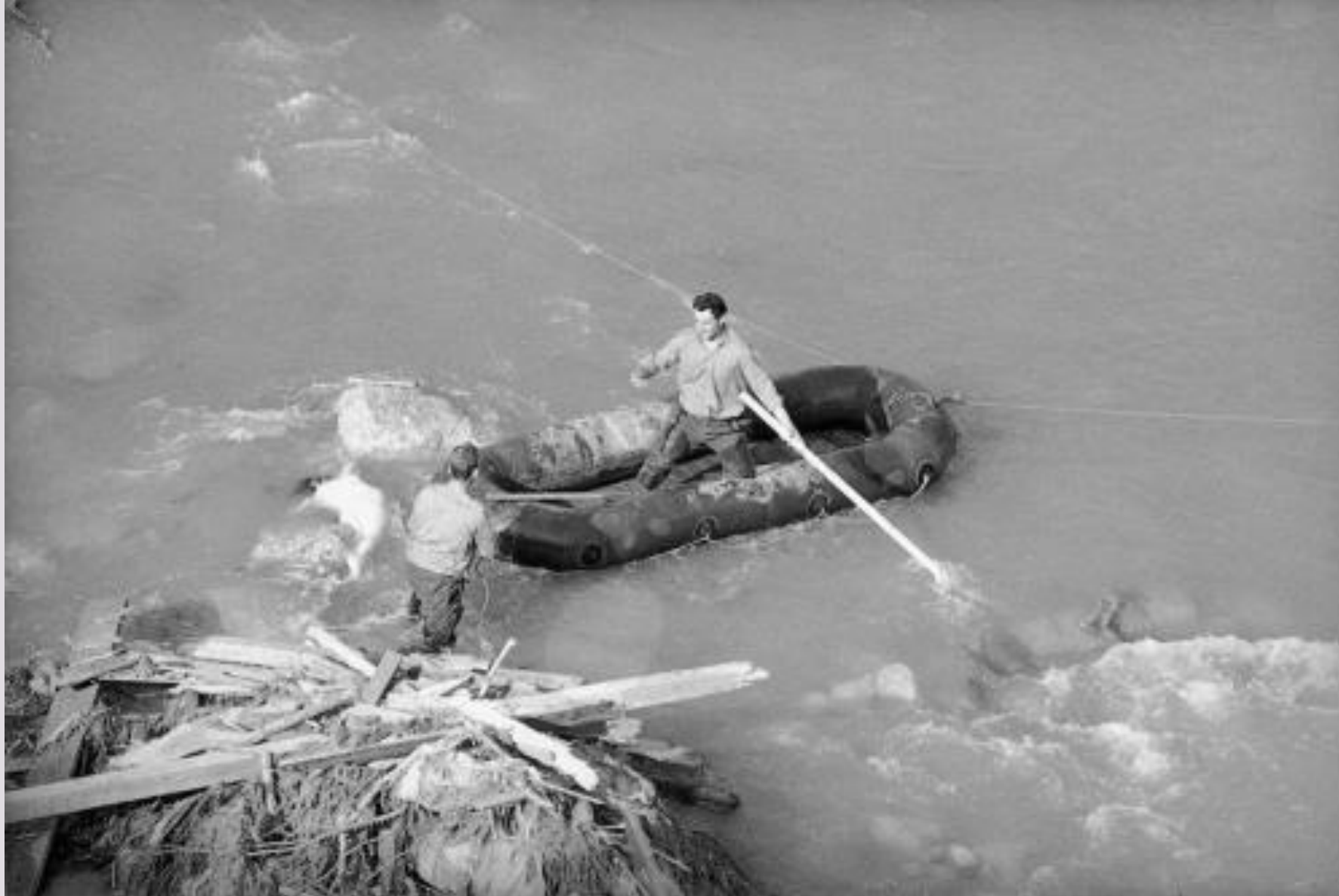
Disastro del Vajont, 1963 - soldati a bordo di un gommone attraversano il torrente Maé per recuperare un corpo.
